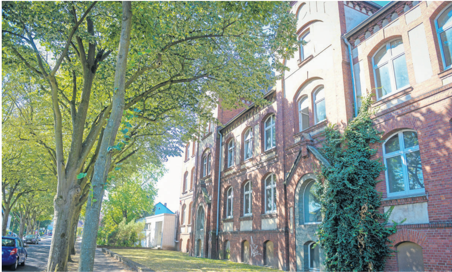
Die frühere Justus-von-Liebig-Schule (im Bild) an der Ernst-Holla-Straße wird entkernt, die ehemalige Tannenschule abgerissen. Hier und auf einem Streifen an der Kirschenallee entstehen mehr als hundert Wohnungen.
